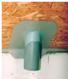
Рисунок 2.27. Примеры выполнения качественной герметизации вентиляционных трубопроводов в здании
