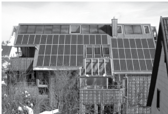
Рис 4.7. Здание, оборудованное солнечными электрическими батареями
