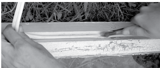
Рисунок 2.21. Устройство паза фрезой и установка теплоизоляционной трубки в прорезанный паз оконной рамы
