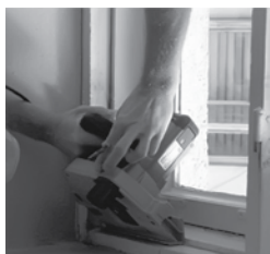
Рисунок 2.21. Устройство паза фрезой и установка теплоизоляционной трубки в прорезанный паз оконной рамы
