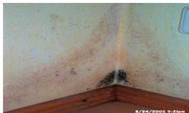
Рисунок 2.28. Микробиологические поражения внутренних стен зданий и конденсация влаги на них вследствие снижения воздухообмена
