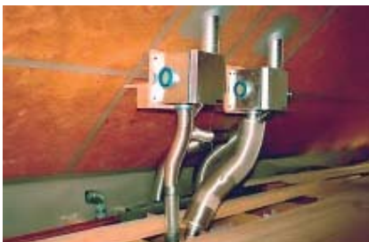
Рисунок 2.27. Примеры выполнения качественной герметизации вентиляционных трубопроводов в здании
