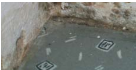
Рисунок 2.28. Микробиологические поражения внутренних стен зданий и конденсация влаги на них вследствие снижения воздухообмена
