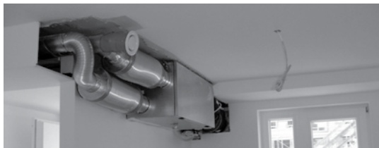
Рисунок 2.31. Монтаж теплообменника для системы вентиляции в помещении
