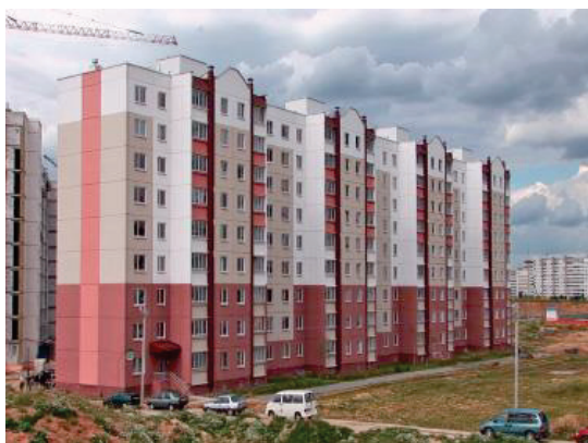
Рисунок 15. Энергоэффективный жилой дом по ул. Притыцкого
