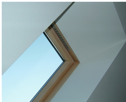
Вентиляционные отверстия в оконной раме
