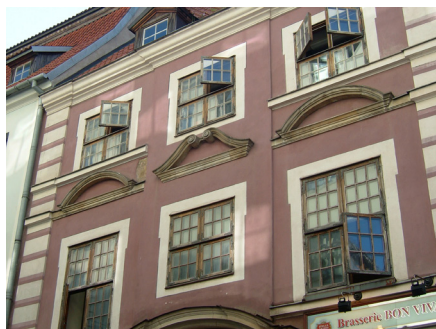
Старые окна в исторических зданиях
