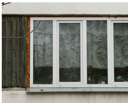
Неправильно установленные окна
