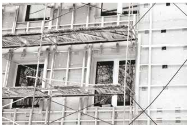
Рисунок 4. Подготовка опорной конструкции для вентилируемого фасада в Минске (слева). Завершенное строительство (справа).
