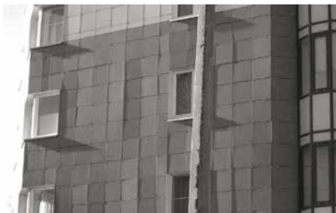
Рисунок 4. Подготовка опорной конструкции для вентилируемого фасада в Минске (слева). Завершенное строительство (справа).
