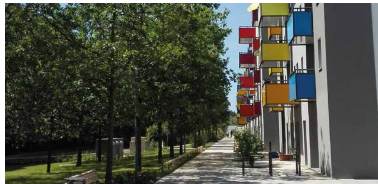
Панельный дом в микрорайоне Дрейвиц после реконструкции
