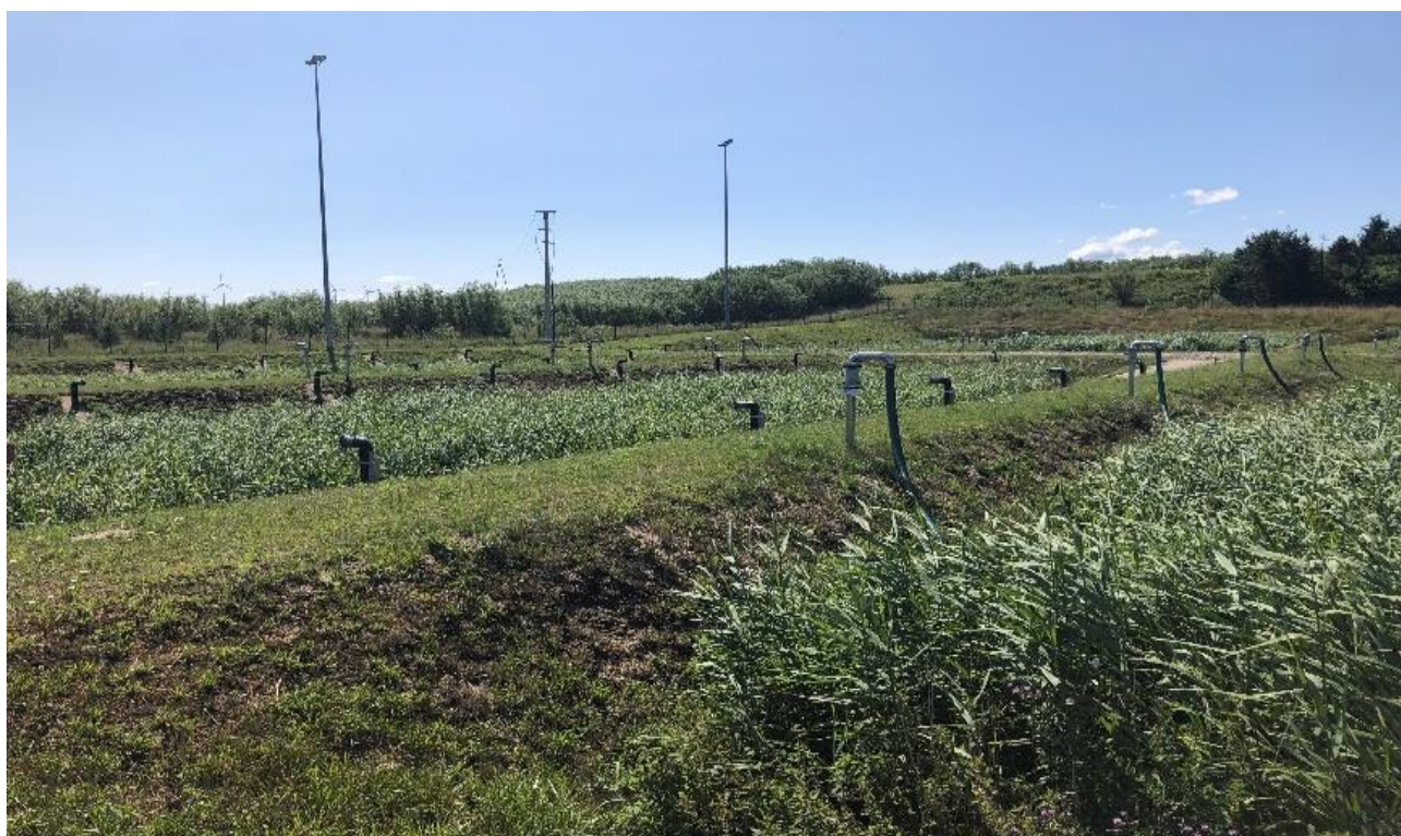
Очистные сооружения канализации Сваржево
