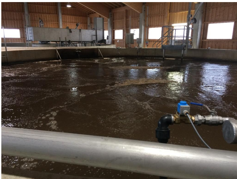
Аэротенк с пластинчатыми аэраторами
