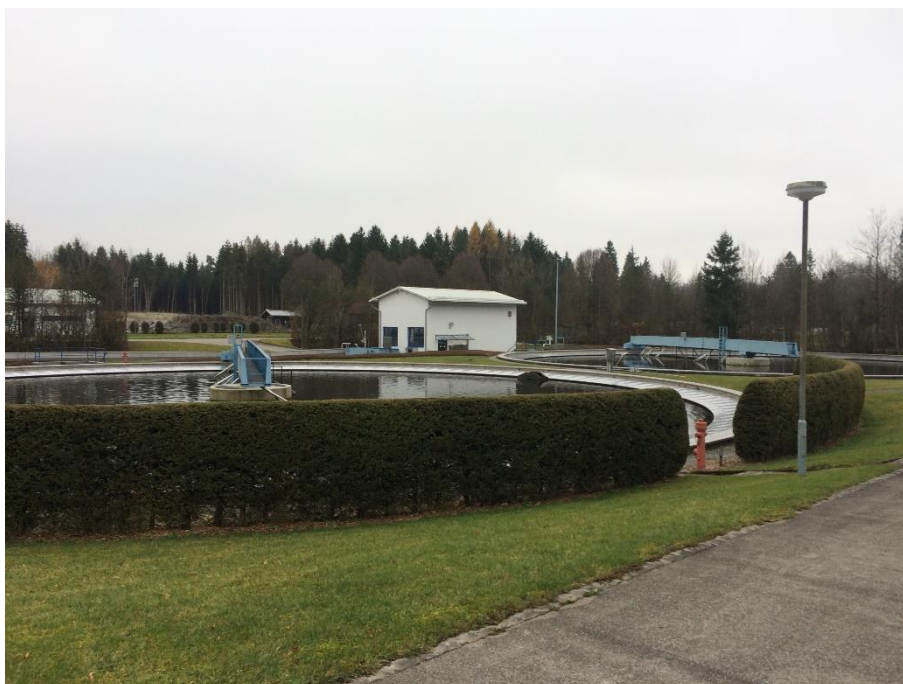
Аэрируемый пруд на территории станции очистки сточных вод г. Бад Тёльц
