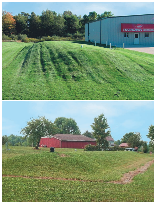
Рис. 2.13. Внешний вид наземных песчано-гравийных фильтров.
