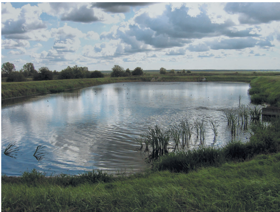
Рис. 2.1. Биологический пруд с естественной аэрацией.
