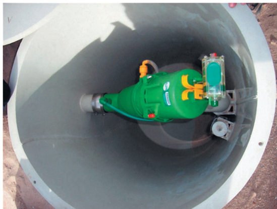
Рис. 1.11. Вид вакуумного клапана и смотрового колодца со смонтированным клапаном.
