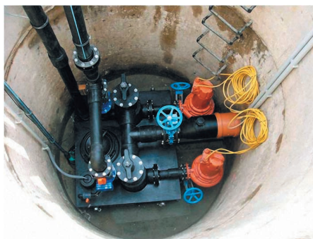
Рис. 1.9. Вид смонтированного оборудования насосной станции с разделением примесей.
